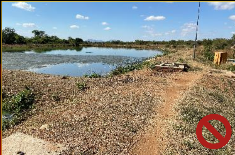
A: Musina Local Municipality WWTW
